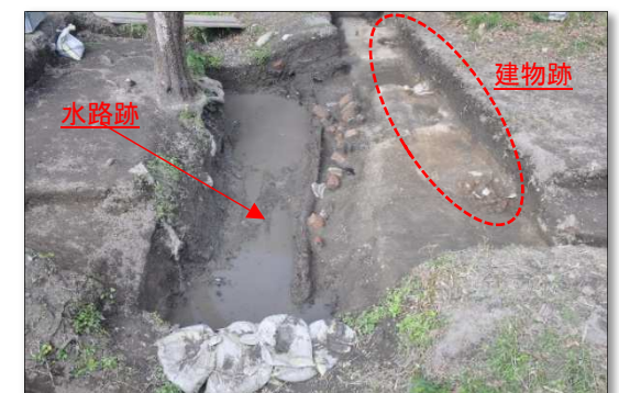
写真2 令和元年度調査：精煉方期の可能性が高い建物跡と精煉合資会社期と推定される水路跡
