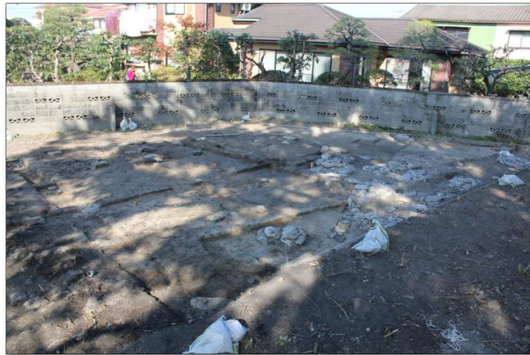
1. R4 年度調査区全景（南東側から撮影）
