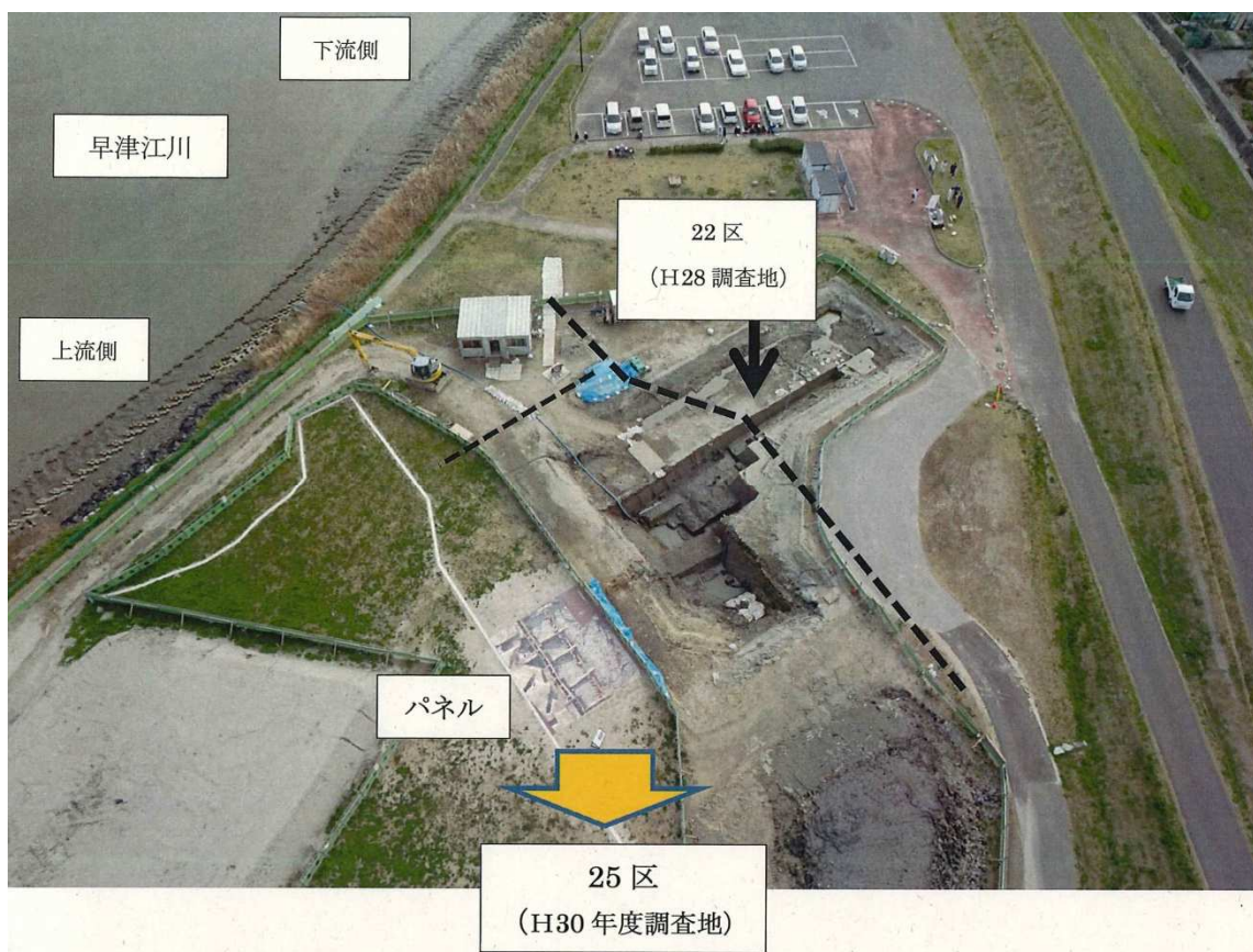
ドライドックと調査地点（俯瞰写真）[北から]
