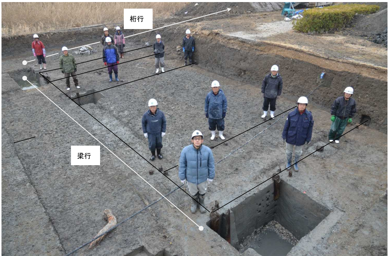
建物端部を俯瞰した写真
