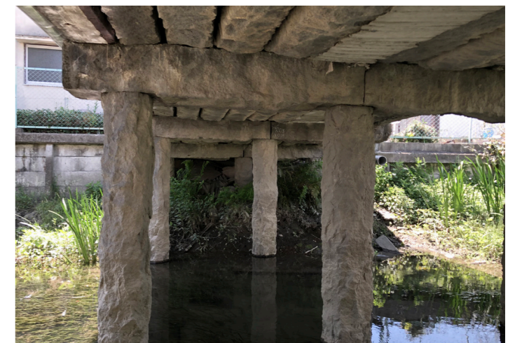
石の橋脚と橋桁
