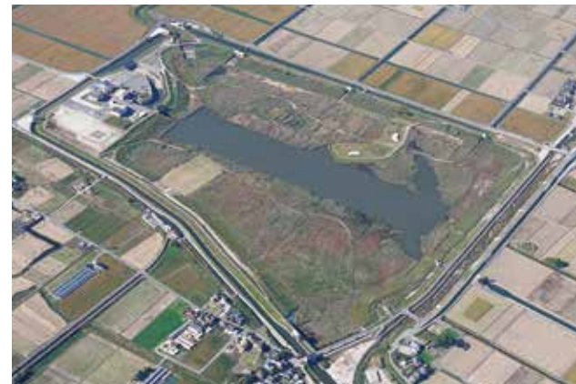
巨勢川調整池全景
