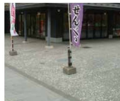
貝殻入りアスファルト施工例
