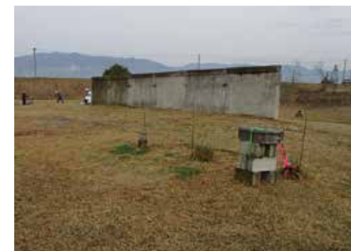
第4貝塚観測孔とL型擁壁
