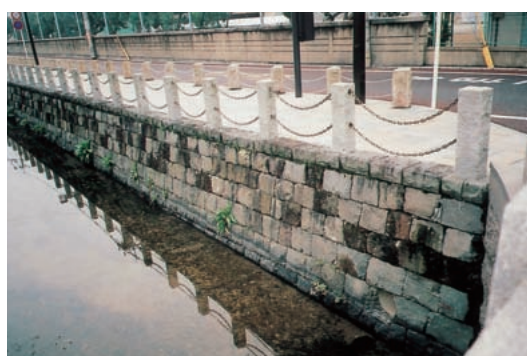
▲改修された石垣護岸。一部に「赤石」が使われている (県庁南側)
