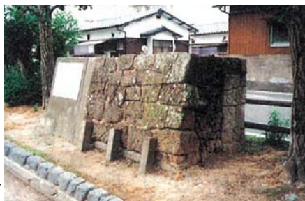
移設復元された石垣護岸
