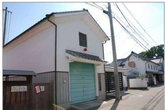
柳町地区コミュニティ消防センター（柳町）
