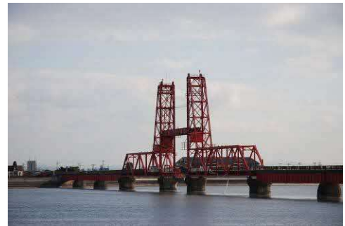
旧筑後川橋梁(筑後川昇開橋)
