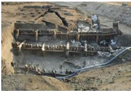
■国指定史跡 三重津海軍所跡 (ドライドックの築壁骨格)
