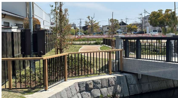
【① 造成、園路、広場整備】
