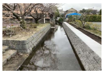
2. 水路護岸の整備【施工済】
