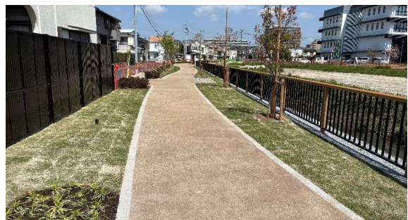
【② 造成、園路、広場整備】
