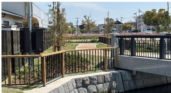
【① 造成、園路、広場整備】 (令和7年4月4日撮影)
