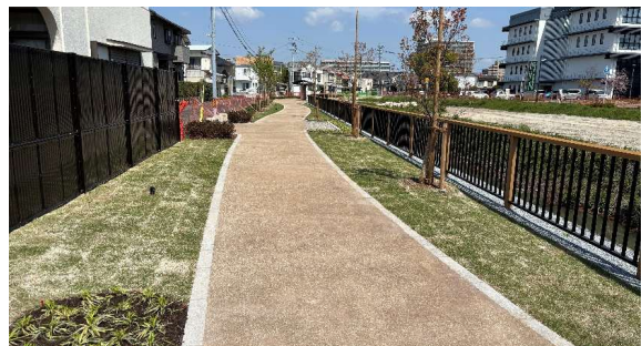
【② 造成、園路、広場整備】 (令和7年4月4日撮影)
