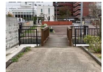
1. 連絡通路 奥は駐車場 B
