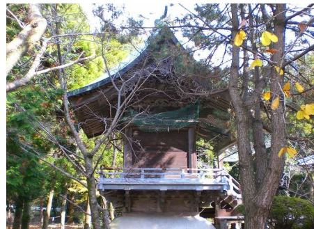
勝宿神社本殿一棟 市重要文化財(建造物) 所有者等 勝宿神社
