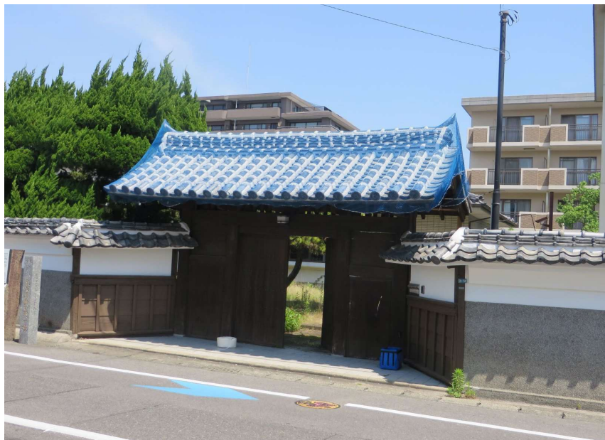
【重要文化財「武家屋敷の門(中の小路)」】
