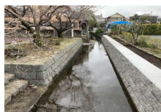
2. 水路護岸の整備【施工済】
