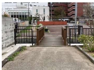
1. 連絡通路 奥は駐車場B
