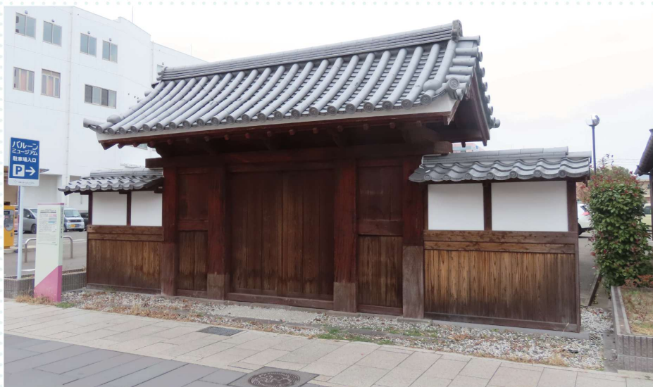
旧嬉野家の武家屋敷の門(薬医門1棟)
