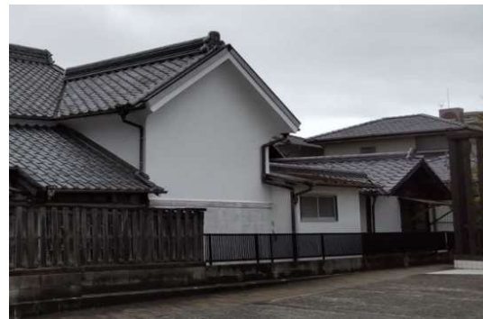
【修理後(漆喰壁)】
