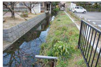
2. 取付護岸整備
