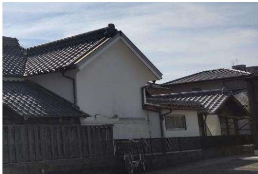
【修理前(漆喰壁)】
