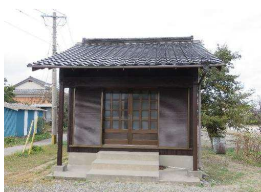
【東崎ヶ江地蔵堂改修】
