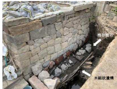
北側石垣護岸 南東から
