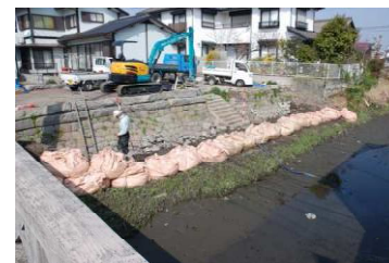
【既存コンクリート護岸撤去後】
