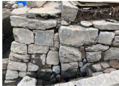
石垣護岸 幕末～明治期 江戸中頃～後期 北から
