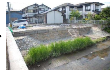
【護岸工事 完了】
