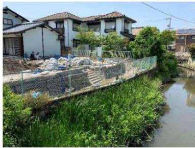
思案橋から対象地を望む 南東から
