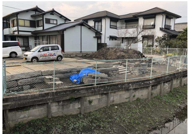
【着工前 (長崎街道側から)】
