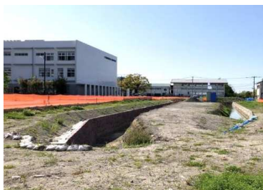
①復元整備中東堀(北側より)
