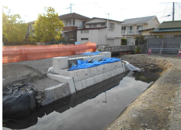
【② 人道橋下部工】
