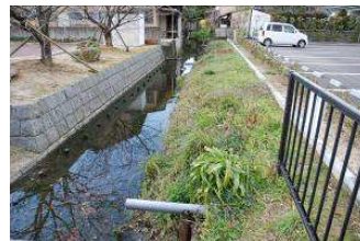
2. 取付護岸整備
