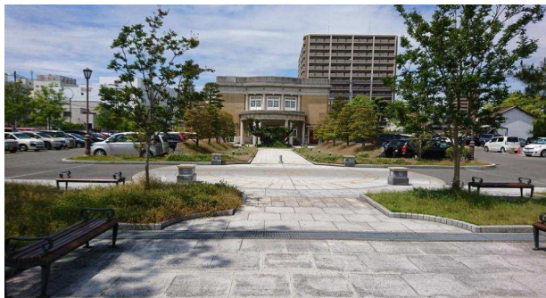
【松原公園第一期整備エリアの現況(南から)】
