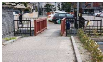
1. 連絡通路 奥は駐車場B、架替する木橋
