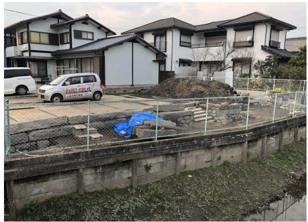
【着工前 (長崎街道側から)】
