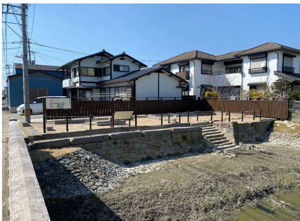
【完成後 (長崎街道側から)】
