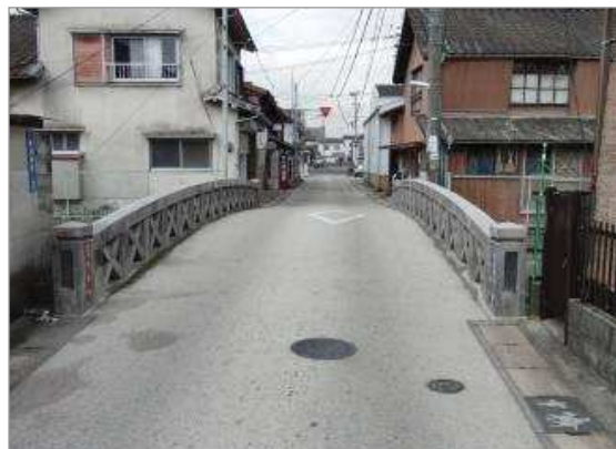
【アスファルトで橋面が覆われている思案橋】
