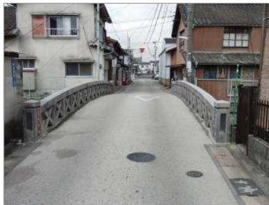
【アスファルトで橋面が覆われている思案橋】
