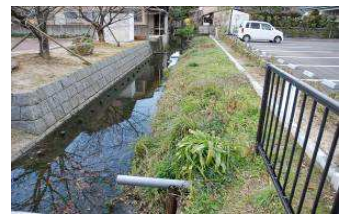
2. 取付護岸整備
