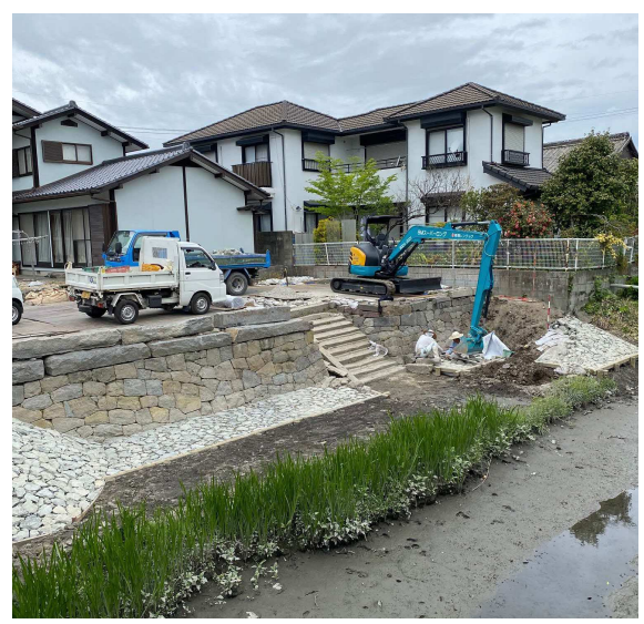
【護岸工事 施工状況】
