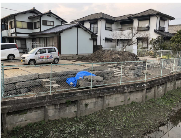
【着工前(長崎街道側から)】
