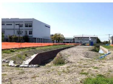
①復元整備中東堀(北側より)
