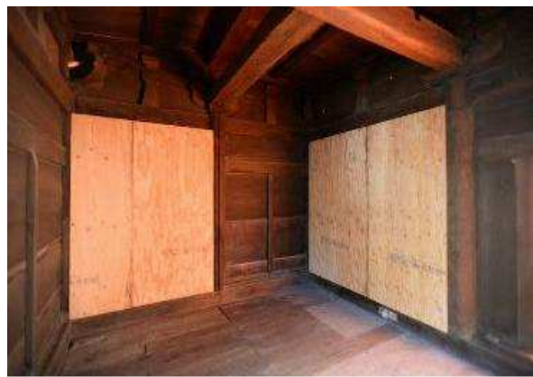
【耐震補強工事(合板補強)】
