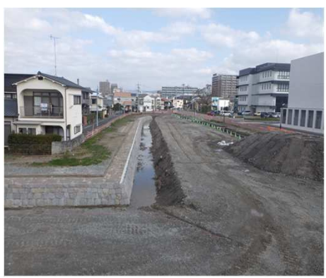
【① 西側石積施工完了(南から)】
