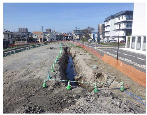
【② 東側石積施工状況(南から)】
