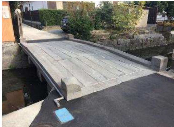
【橋面に石橋が見える成就院橋(改修後)】
