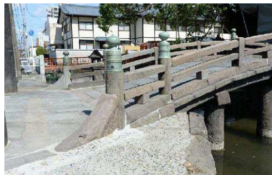
【石橋高欄(南面)】
