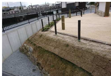
石垣修復・公園整備完了
