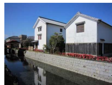
石積護岸の整備 H28.6
