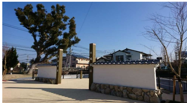
公園整備完了
