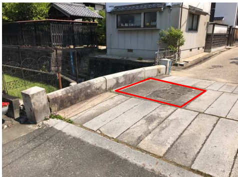
【改修前】 一部コンクリート補修箇所あり
