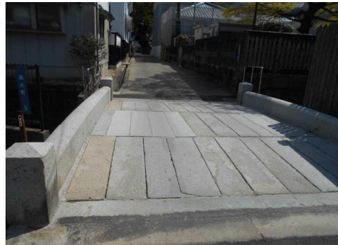
【改修後】 コンクリート補修部分に新規橋板設
