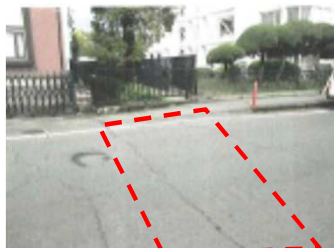
裁判所前の橋
