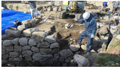
【石垣保全修復工事状況】
