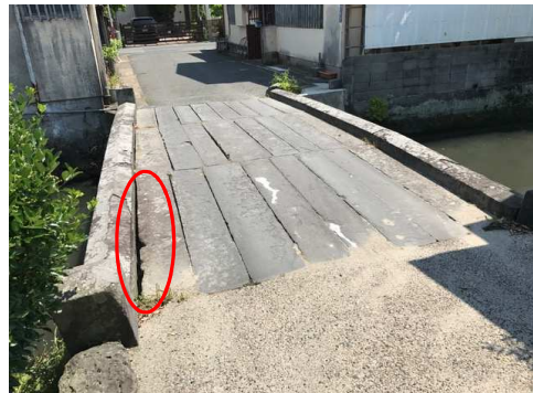
隙間のある石橋 (成就院橋)
