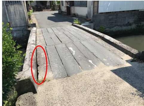
隙間のある石橋 (成就院橋)
