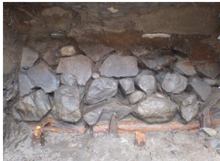
東堀裏御門橋側壁石積(重点区域内)
