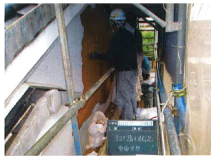
既存漆喰剥取状況
