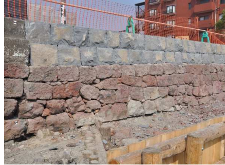
西堀護岸石検出状況(重点区域内)
