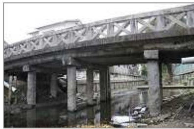
左写真の石橋を横から撮影 (思案橋)
