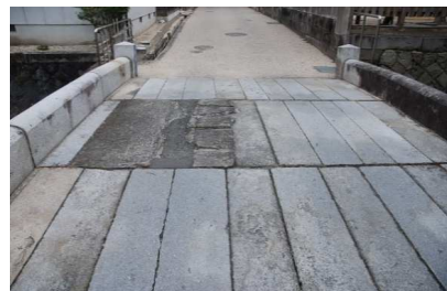
コンクリートによる補修 (古賀善橋)
