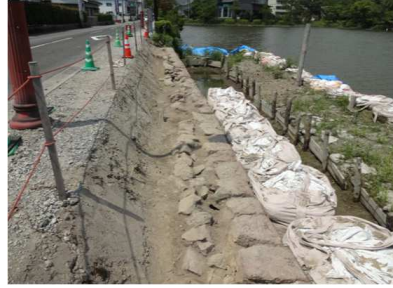
西堀天端石と押さえ石検出状況(重点区域内)
