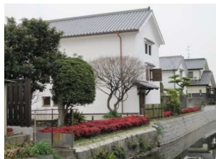
整備後①旧森永家の護岸改修
