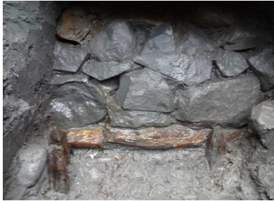
東堀土橋南面石積(重点区域内)
