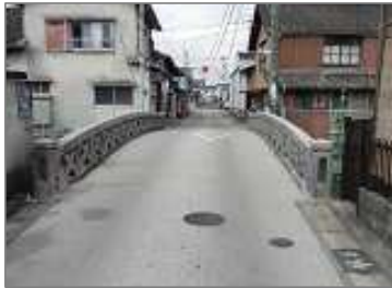
アスファルトにかくれた石橋
