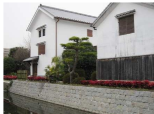
整備後②旧牛島家の護岸改修
