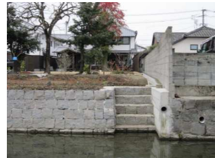
整備後③旧久富家の護岸改修・柵路の復元
