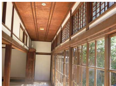
破損状況(柱の倒れ)
