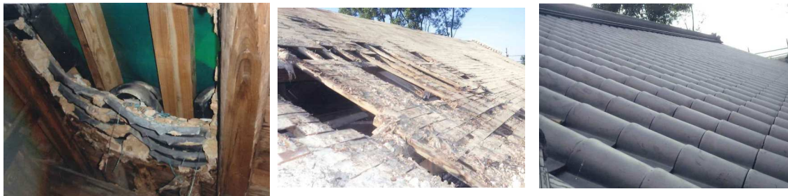
高伝寺御位牌所〔市重要文化財〕の修理(屋根修理)
