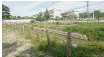
裏御門橋南側護岸
