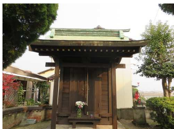
諸富自治会: 観音堂修繕
