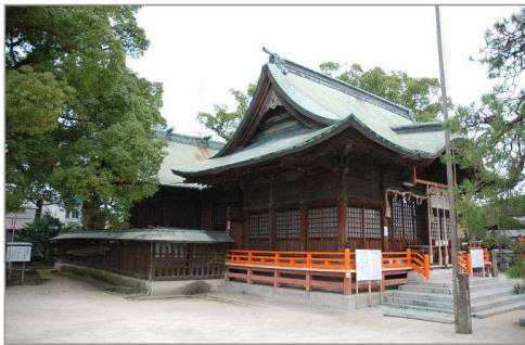
与賀神社本殿・幣殿・拝殿 〔国登録有形文化財(建造物)登録(H25.6.21告示)〕 本殿・幣殿・拝殿を一直線に接続した複合社殿 現存する本殿と拝殿の棟札は、宝暦8年(1758)・ 宝暦9年(1759)とある。
