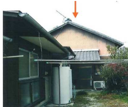
壁面の改修 変更前(トタン) 長崎街道・柳町景観形成地区
