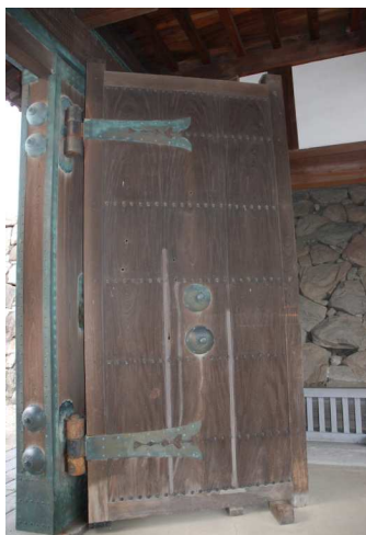
修理を予定していた門扉 佐賀城鯨の門及び続櫓[重要文化財]
