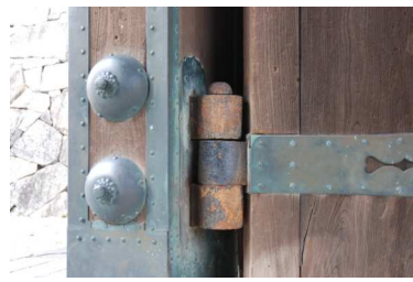
修理を予定していた蝶番部分の拡大 佐賀城鯨の門及び続櫓[重要文化財]
