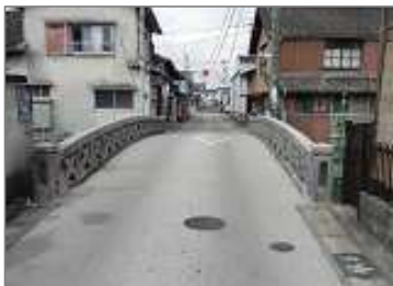
アスファルトにかくれた石橋
