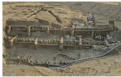
三重津海軍所跡 写真は、在来の土木工法による幕末期の 船渠(ドック)
