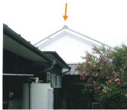
壁面の改修 変更後(漆喰) 長崎街道・柳町景観形成地区
