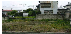
建築物の新築及び生垣の設置(着工前) 城内景観形成地区
