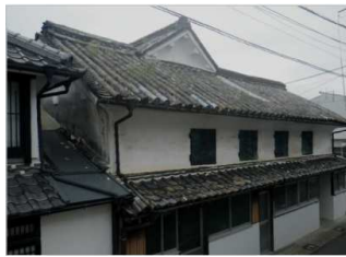
屋根の修繕 改修前 景観重要建造物・南里邸
