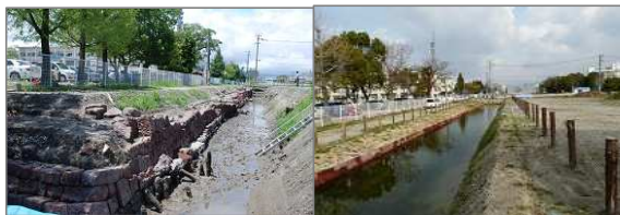
文化財調査で発掘された 復元前の赤石護岸 復元された東堀の赤石護岸
