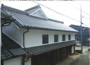
屋根の修繕 改修後 景観重要建造物・南里邸
