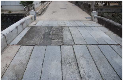
コンクリートによる補修
