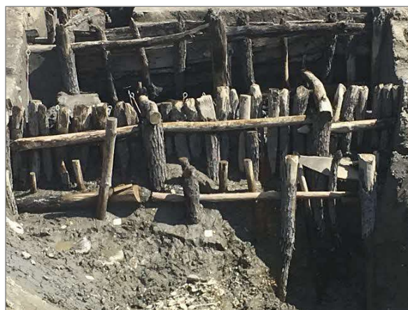
発見されたドライドックの木組遺構 三重津海軍所跡[史跡]
