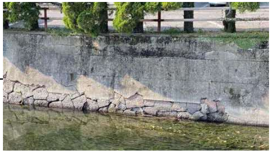
一部露出している赤石積の護岸
