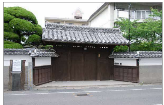
武家屋敷の門(中の小路)
