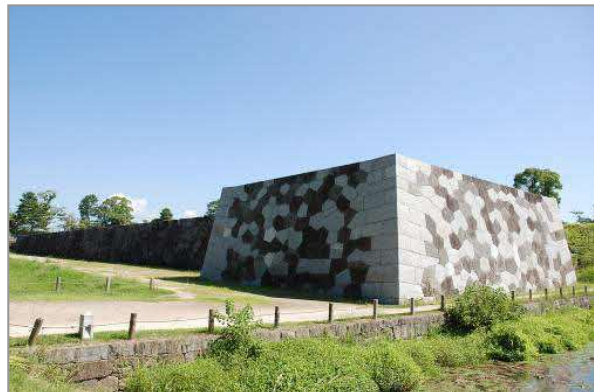
復元された本丸櫓台と石垣
