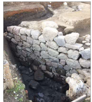
佐賀城下東入口に架かっていた橋の土台の石垣（南面）
