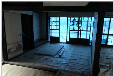
歴史的建造物等を生かした 交流とにぎわいづくり事業(井徳屋) 〔着工前〕
