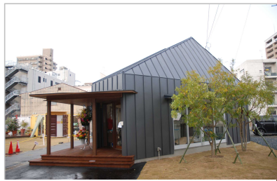
新築された建築物のファサード整備 〔竣工〕
