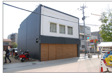
既存建築物のファサード整備 〔竣工〕
