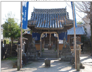
八坂神社の屋根の修復(着工前) 長崎街道・柳町景観形成地区
