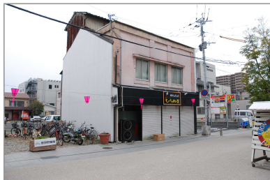
既存建築物のファサード整備 〔着工前〕
