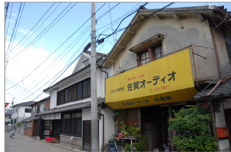
附属土蔵 履物の倉庫として利用されていた土蔵
