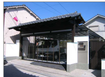
門扉の新設(竣工) 長崎街道・柳町景観形成地区
