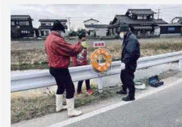
水難救命具の設置（蓮池）
