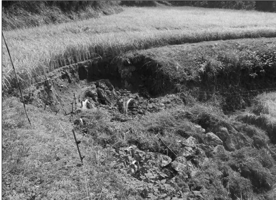
○農地・農業用施設災害 台風10号(富士町上無津呂地区)
