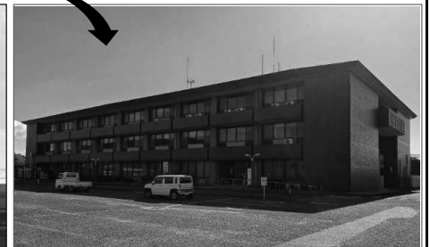
大和支所 (改修工事後：2階に移転)
