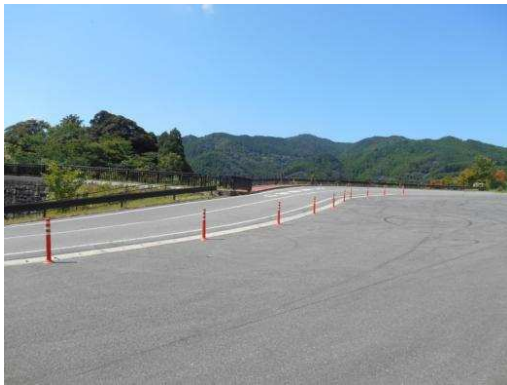
施工後写真 （左：ポール 右：チャッターバー）
