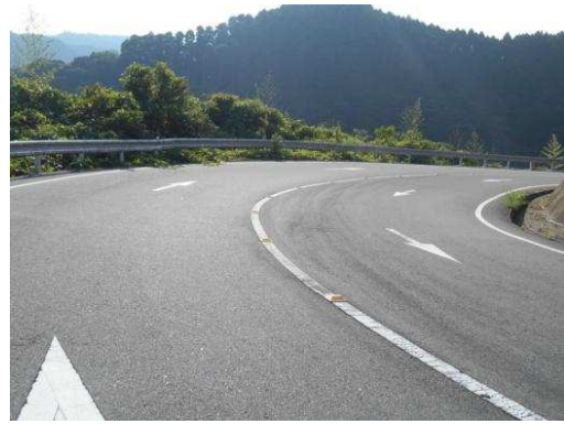
施工後写真 （左：ポール 右：チャッターバー）
