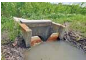
▲田んぼに切れ込みのあるせき板を設置。 約280haで実施(25mプール933杯分を貯留)
