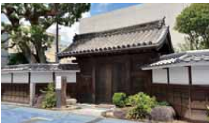
▲武家屋敷の門(佐賀市重要文化財／水ヶ江2丁目)
