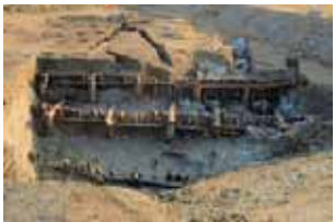
▲ドライドックの木組み護岸遺構
