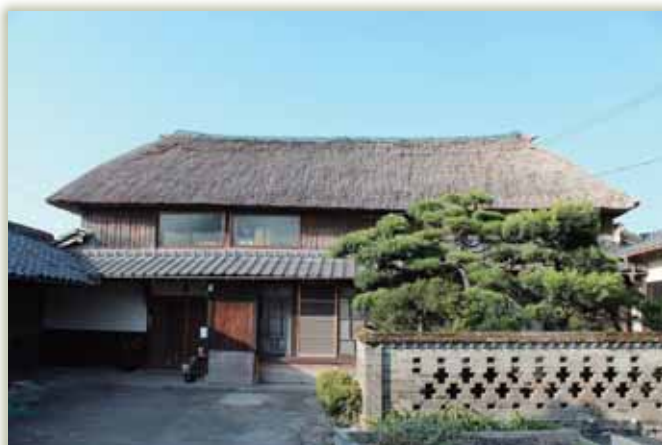
所在地：川副町早津江 構造：木造 2 階建 完成年：江戸時代末頃
