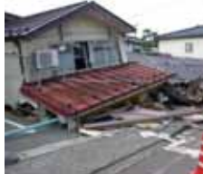
▲熊本地震では古い住宅が被害を受けました。
