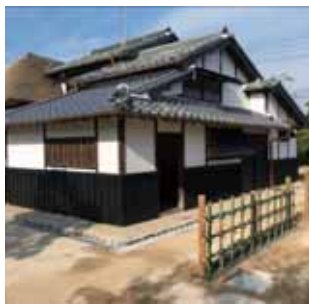
▲保存改修工事が完了し、約1年ぶりに内部を公開
