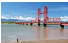
▲筑後川昇開橋
