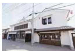
旧久富家住宅外観
