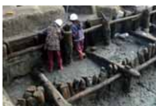
▲日本最古のドライドックの護岸遺構
