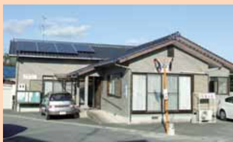
▲自治公民館に設置された太陽光発電システム（寄人公民館）
