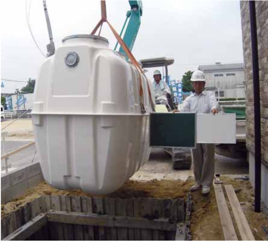
▲浄化槽の据え付け状況
