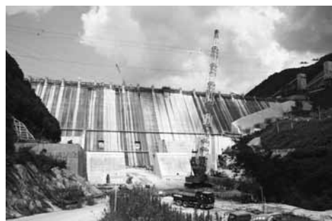
ダム本体工事の様子
