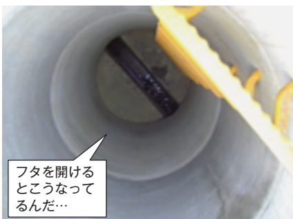
この溝の部分を「インパート」と言います。汚水が流れる部分です。
