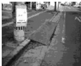
板等での乗り入れや電柱等への張り紙は禁止されています
