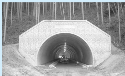
▲着々と工事が進んでいます。
