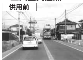
佐賀市側より神埼市方面を撮影
