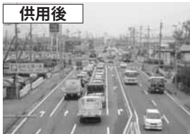
↑ 左折車線設置
