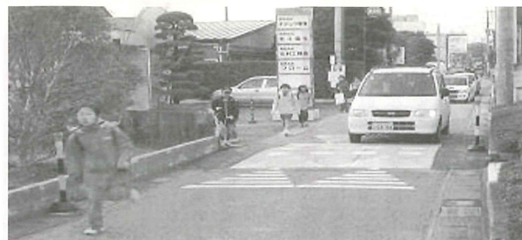
日新・新栄地区交通環境改善社会実験 (自動車の速度抑制のための道路上のハンプ)
